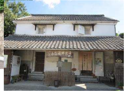
明治後期に建てられた木綿蔵 現在は機織り体験や製品販売工房
